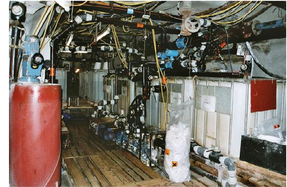
Anlage zur Herstellung  $\text{BaSO}_4$ -bildender Lösungen im Sanierungsbetrieb Königstein der Wismut GmbH
